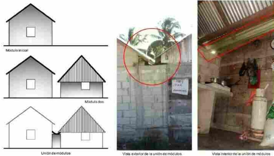
Figura 9. Canaleta para desalojo de aguas pluviales.
